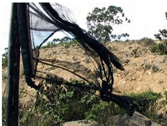
Les restes d'un atrapanieblas construit en haut de la montagne El Tofo, 2006, © MLN.
