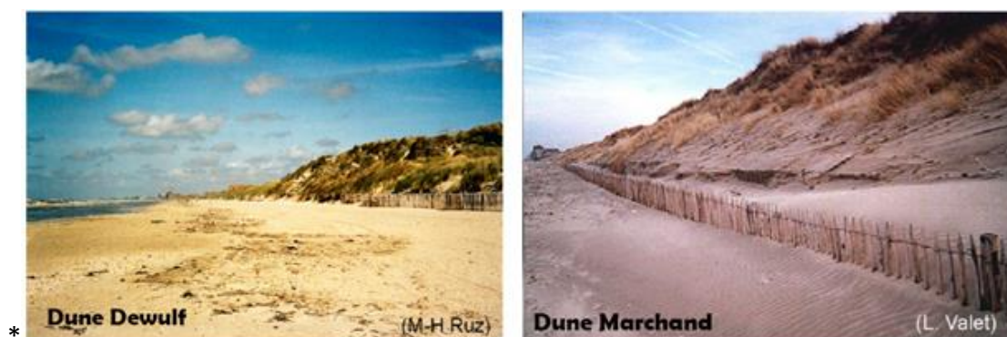
Figure IV-17 : mise en place de rangées de ganivelles au niveau de la dune Marchand (en 2005) et Dewulf (en 2002).
