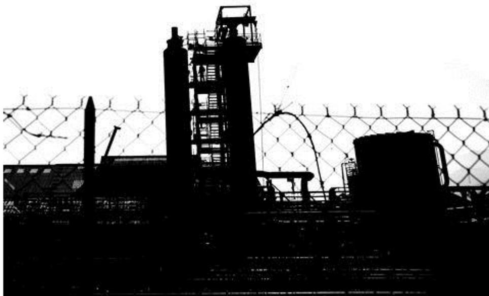
Et au fait, que produit Arkema-Jarrie ? De l'amiante ? Pas du tout : du chlore et des dérivés. « Avec de l'énergie électrique et pour matières premières le sel, l'éthylène ou le méthanol, l'usine fabrique de grands intermédiaires chimiques (chlore, soude, hydrogène, chlorate de soude) qui sont ensuite utilisés pour produire de l'eau de Javel, du dichloréthane, de l'eau oxygénée, du perchlorate de soude, et des dérivés chlorés (Jarylec® et chlorure de méthyle) » (\*)
