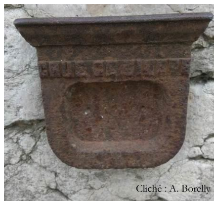
Figure 4 : Exemple de repère de crue de Grenoble
