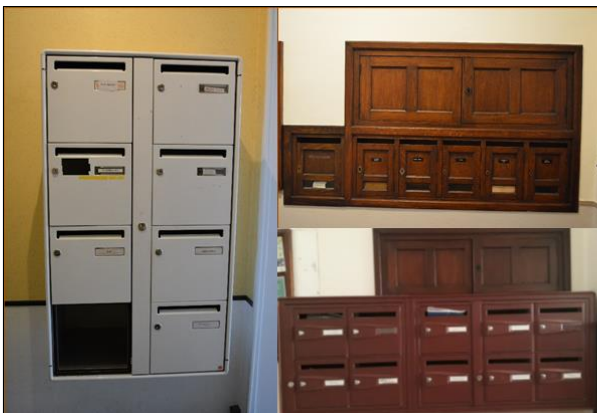
Figure 37 : Exemples de boîtes à lettres observées dans les immeubles de la Neustadt , source © Blanc 2016
