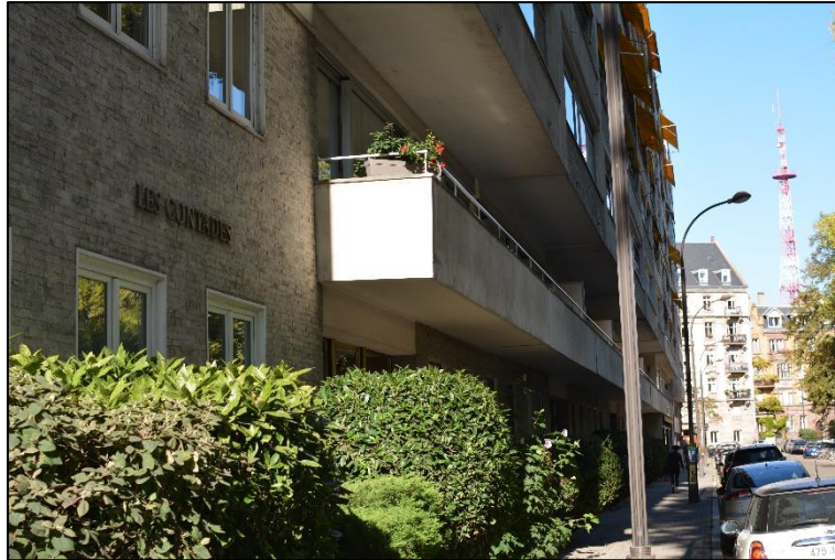
Figure 23 : Vues des barres d'immeubles aux abords des Contades, © Blanc
