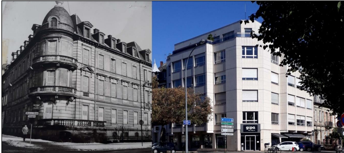
Figure 24 : Montage avant après à l'angle de la rue Goethe ©photographie AVCUS et Blanc
