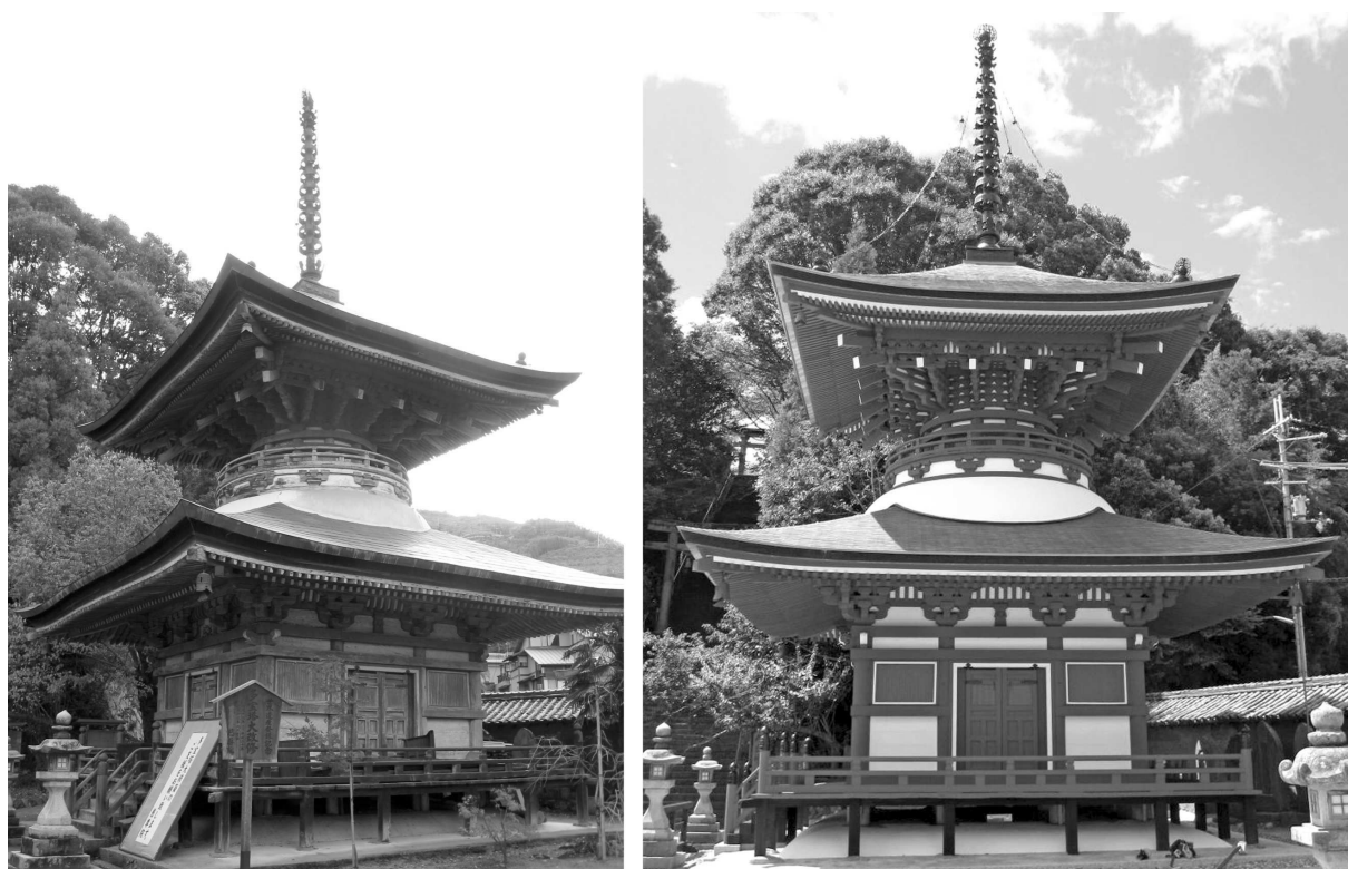
Figure 20 - La pagode du Jison.in avant et après restauration, 2009 – 2012 (photographies Nishizawa Hiroyasu).
