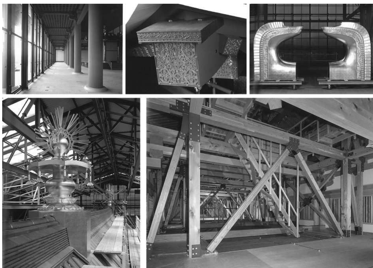
Figure 53 - En haut, de gauche à droite : vue intérieure du pavillon de l'Ultime Suprême ; décors ; les deux shibi , ornements placés aux extrémités du faîtage principal. En bas à gauche : fleuron du faîtage ; à droite : La structure traditionnelle est renforcée par triangulation.
