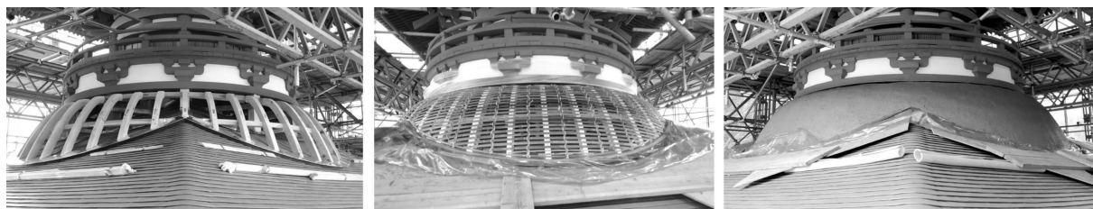
Figure 34 - Trois étapes de la réfection du dôme ( kamebara ), 2010-2012 (photographies de l'auteur).
