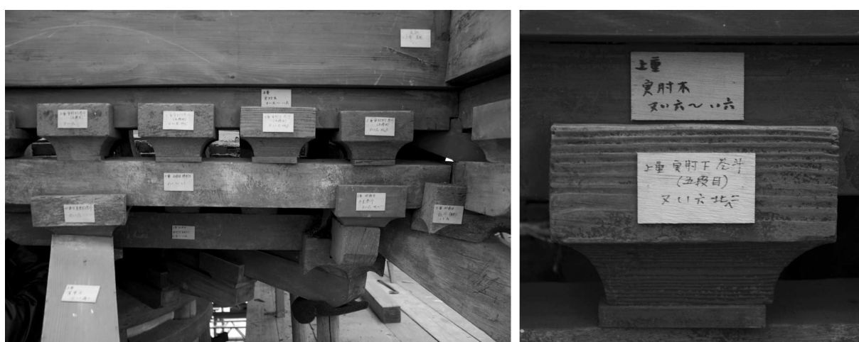
Figure 23 - Étiquettes avec données de situation déposées sur les pièces avant démontage, 2010 (photographies de l'auteur).
