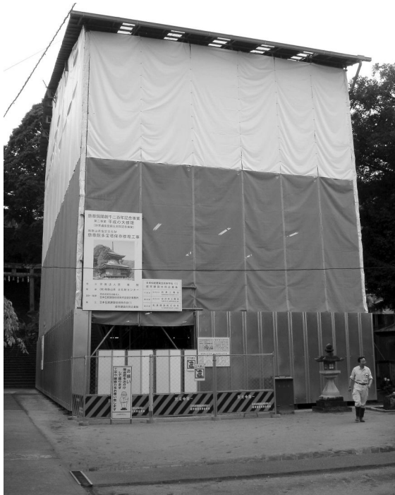
Figure 22 – Échafaudages installés autour de la pagode pendant le chantier, 2010 (photographie de l'auteur).
