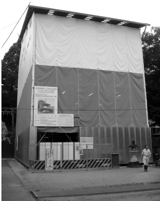
Figure 22 – Échafaudages installés autour de la pagode pendant le chantier, 2010 (photographie de l'auteur).
