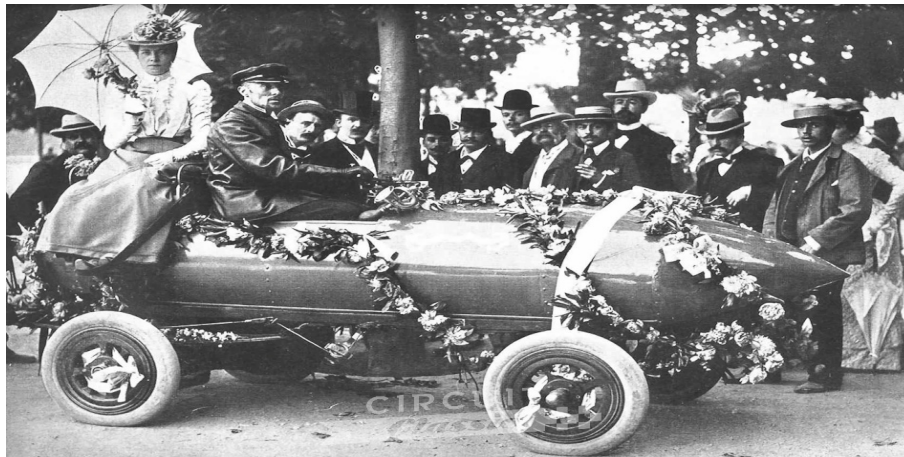
Figure 1.1: La Jamais contente, le premier véhicule électrique à avoir franchi le cap des 100km/h.
