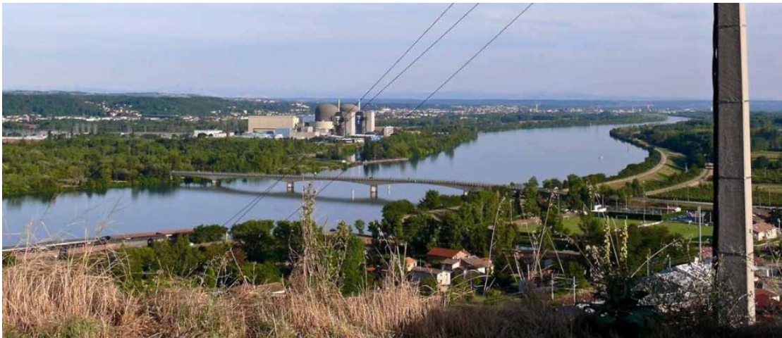
Figure 33 : la centrale nucléaire de Saint-Alban-Saint-Maurice vue du Pilat, 2016 (source : Association Vivre Ici Vallée du Rhône Environnement)
