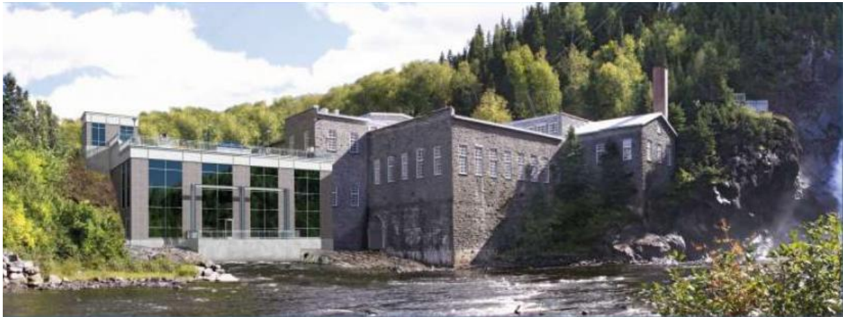
Photographie 19: Simulation de la première version du bâtiment de la mini-centrale depuis la rive gauche
