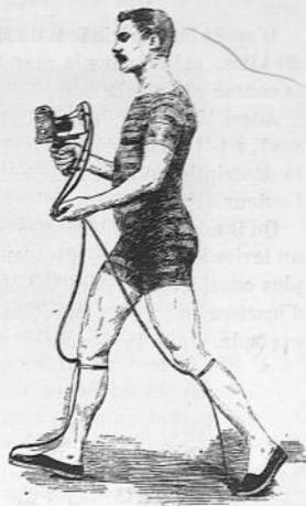
Fig. 155. — Chaussure exploratrice des appuis du pied de l'homme sur le sol; un tube de transmission fait communiquer la chambre à air avec le tambour du chronographe (Marey).
