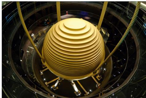
Figure 2.12: La masse d'amortissement passif de Taipei 101
