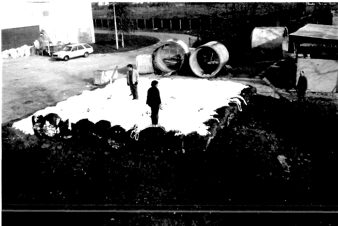
photo 2 : pose du lit de Plasterre.
