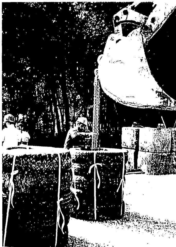
figure 1.12 : Procédé Pneursil (photo CETE BRON 69).
