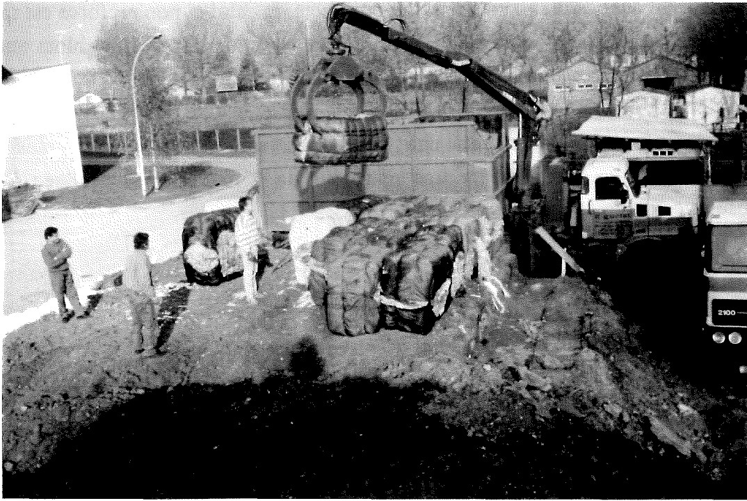
photo 1 : Pose des couches de blocs.
