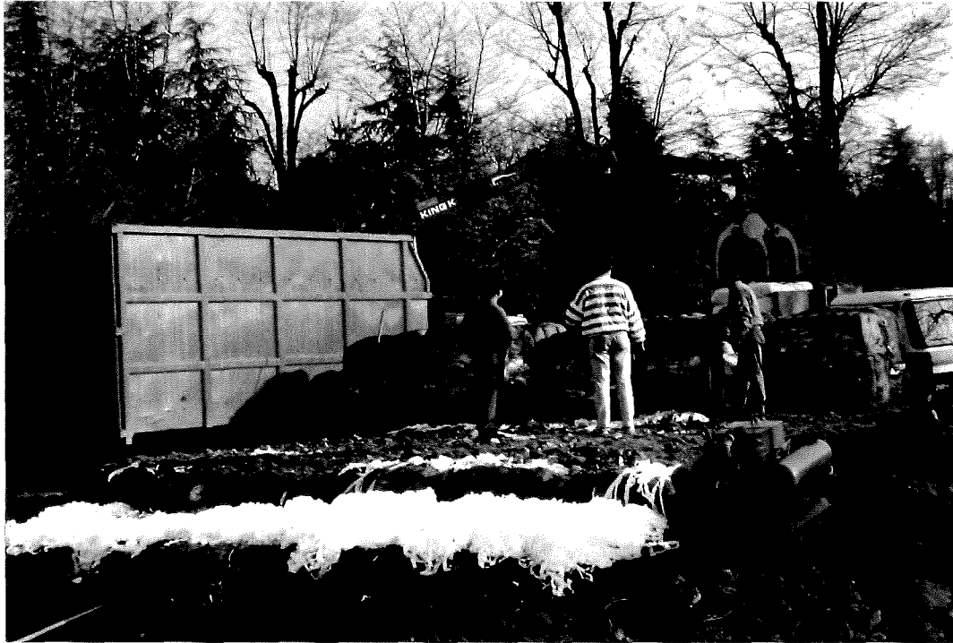
photo 3 : Compactage des talus latéraux au rouleau manuel.
