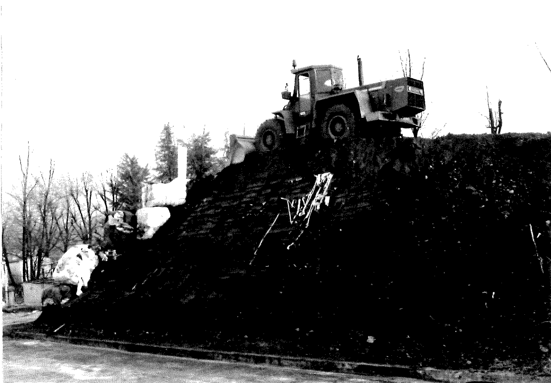
photo 4 : remblai expérimental terminé,
