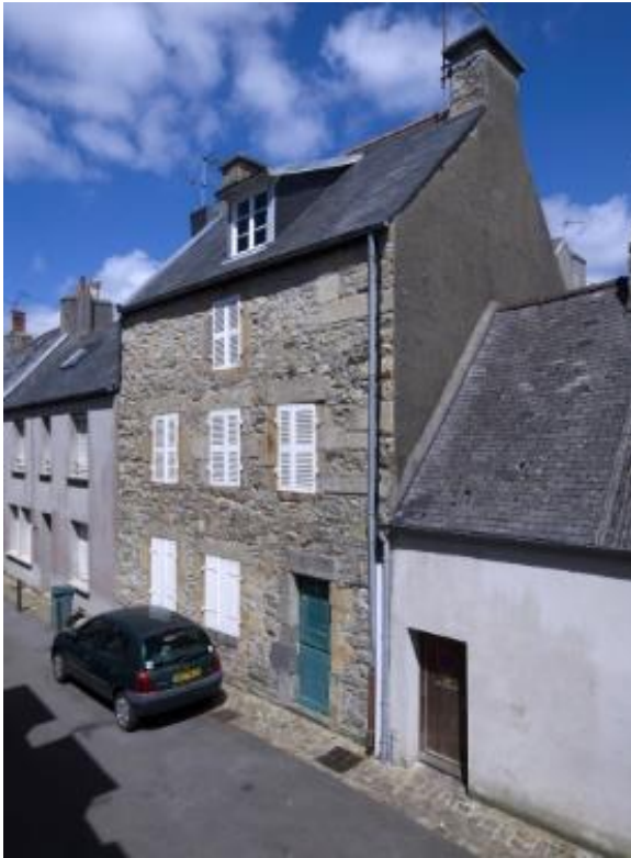
Photographie 9 : maison-commerce, Camaret ( Bègne Bernard, inventaire du patrimoine)
