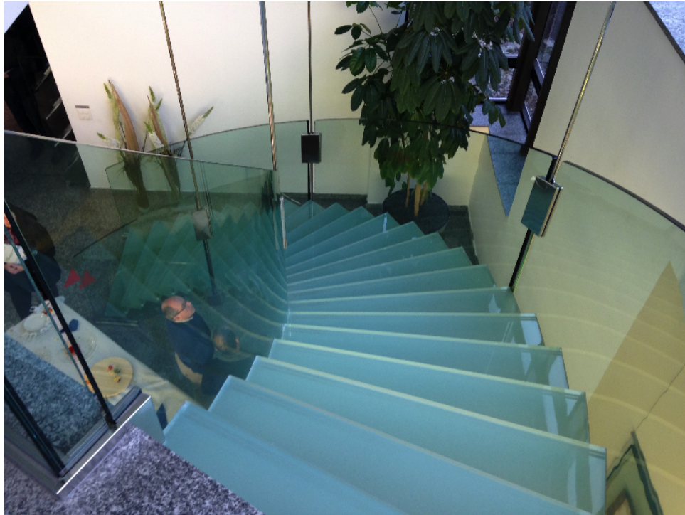
FIGURE 6.2 – Exemple d'escaliers opaques et garde-corps transparents en verre
