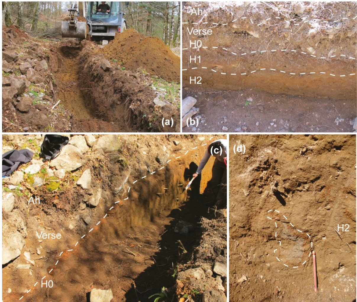
Figure 22 : Photos du profil de Fanay, verse du bas, site B. (a) Aspect de la terre et des stériles pendant les travaux de tranchées. (b) Profil du technosol sous la verse. On distingue 5 niveaux. (c) Profil du technosol, sous la verse, proche de la zone humide. H0 est souligné par le trait blanc pointillé. (d) Structure fantôme de bloc dans le technosol, représentée Figure 10a.
