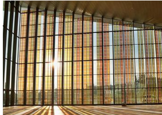
Figure I.4 : DSSC intégrées au SwissTech Convention Center
