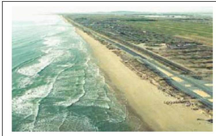
Figure 5 : Erosion du lido entre Sète et Marseillan
