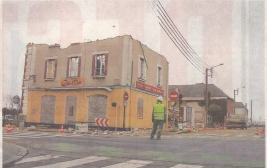
La démolition des maisons, rue de l'Alma, avait suscité beaucoup d'émotion.
