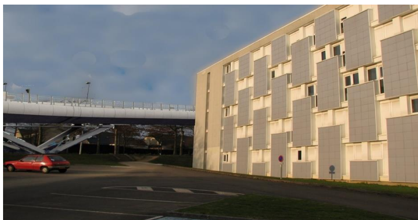
Illustration 18. Viaduc à côté de l'INSA Source : collectif « Sauvons les Longs Champs », viaduc qui passe à quelques mètres de la résidence universitaire de l'INSA
