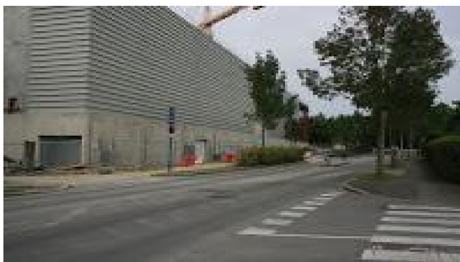
Illustration 21. Rue Papegault après aménagement
