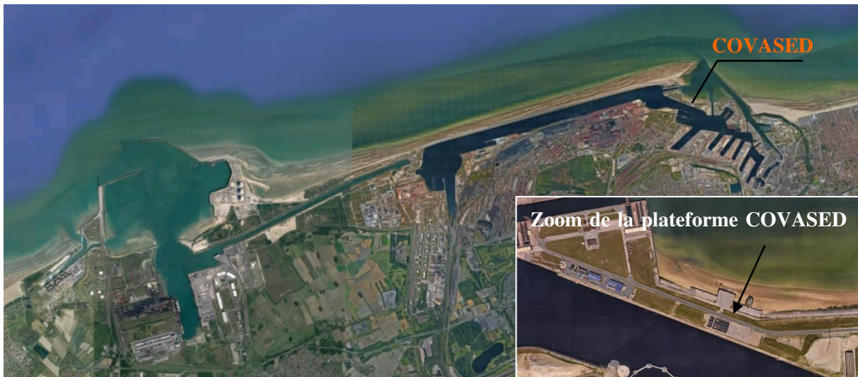
Figure 1-6. Localisation de la plateforme COVASED, dans le GPMD.
