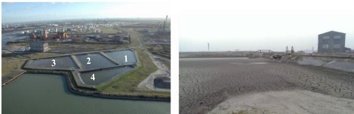
(a) Bassins de décantation remplis.
