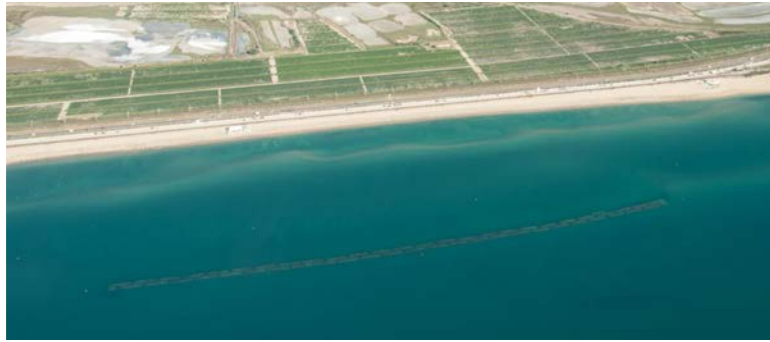
Fig. 1.2 Photo aérienne de la plage du Lido de Sète (Occitanie, France) montrant par transparence les structures sédimentaires immergées (barres pré-littorales) et l'ouvrage atténuateur de houle. Images obtenues via Sète AggloPôle Méditerranée.
