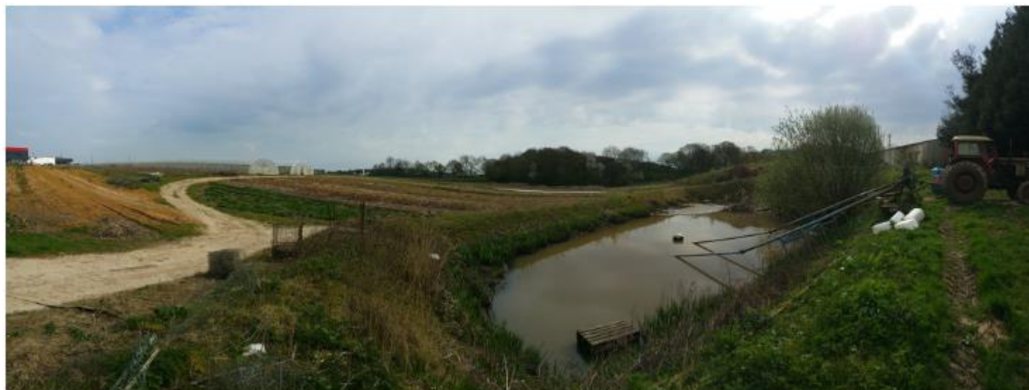
Figure 49 : Bassin de stockage de l'eau d'irrigation sur le site d'exploitation D
