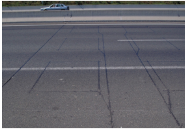
Fig. 3.2.: Boucles électromagnétiques sous la chaussée - Source : transport-intelligent.net
