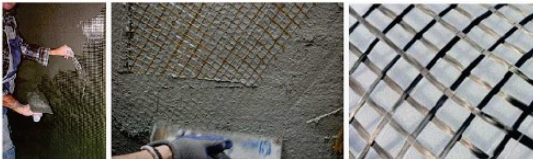
Figure 1. FRCM Matrice cimentaire renforcée par des fibres
