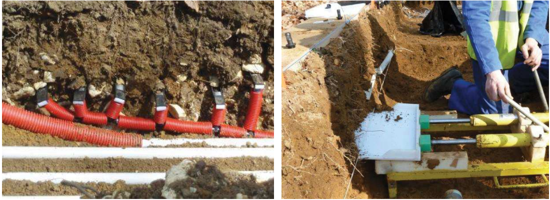
Figure 2-7 : Installation des fluteaux (à gauche) et des plaques lysimétriques (à droite) sur le site de Montiers (source : Marie-Pierre Turpault)
