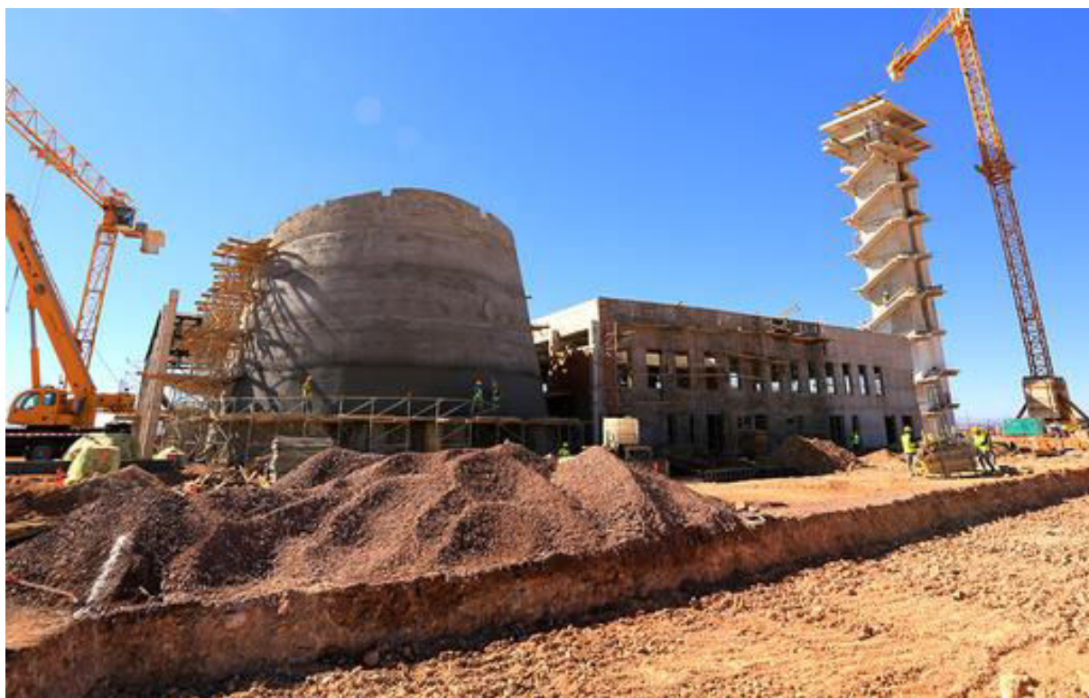
Figure 45: photographie de la construction de la centrale Noor 1
