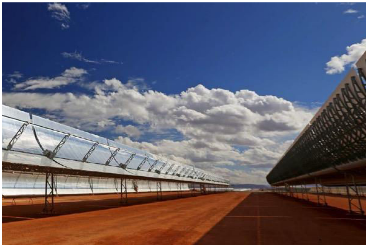
Figure 27 Photographie panneaux paraboliques de la centrale solaire Noor 1
