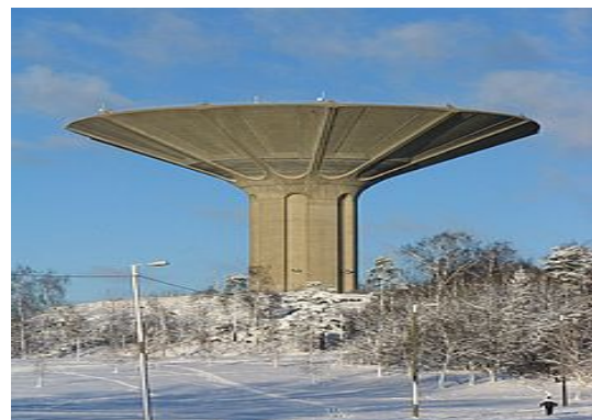
(d) Château d'eau
