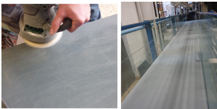
FIGURE 2.3 – Gauche : ponçage du double fond. Droite : double fond PVC dans le canal.
