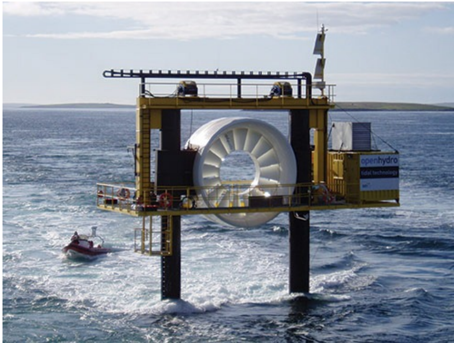
Figure 1.4 : Modèle réduit d'hydrolienne de technologie OpenHydro sur un site de test. ©OpenHydro.
