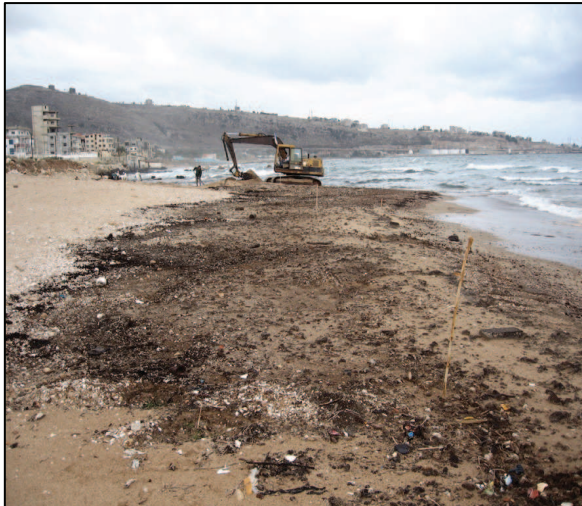
Photo 17 - Situation avant nettoyage avec horizon pollué enfoui et affleurant (Fichaut 2006)
