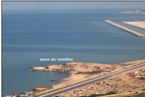
Photo 9 - Site de la décharge à proximité de l'aéroport de Beyrouth (Croizeau, 2007)
