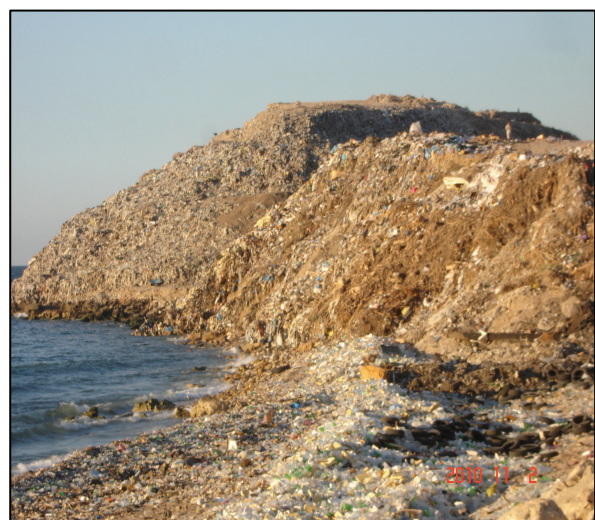
Photo 7 - Décharge de Saïda, à la suite d'une tempête (Tarabay 2011)
