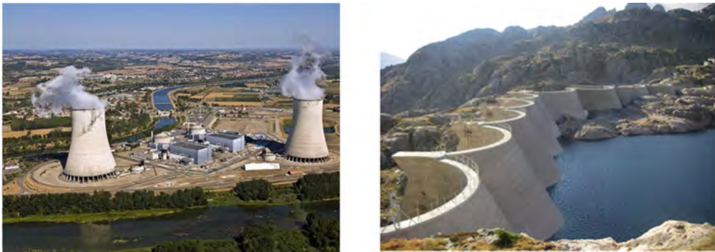
FIGURE 1.1 – Centrale nucléaire de Golfech (gauche) et barrage de Migouélou (droite). Crédits photos www.edf.fr et www.barrages-cfbr.eu .
