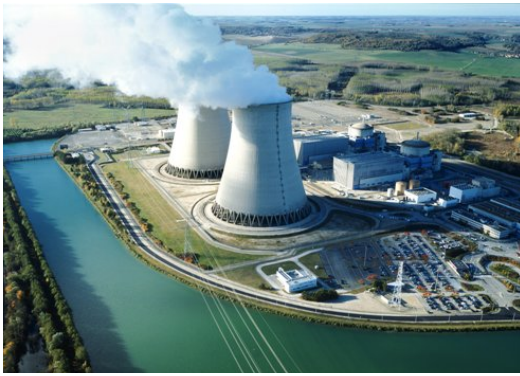
(a) Centrale nucléaire
