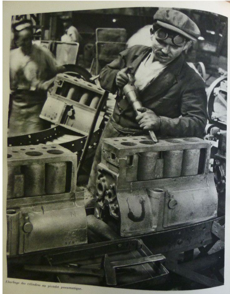
Fig. 27: François Kollar, « Ébarbage des cylindres au pistolet automatique », « Ch. L'Automobile... », La France Travaille , op. cit., T. II, p. 332.
