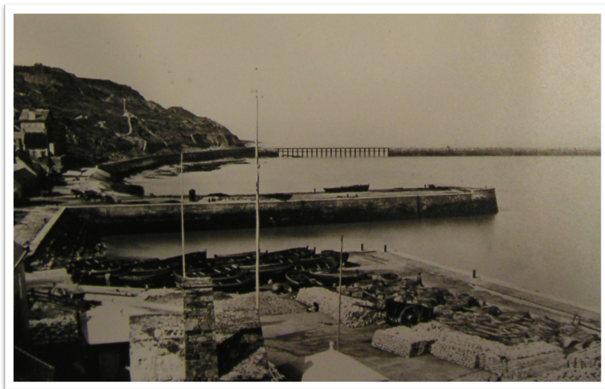
Doc 25 : Photographie de l'estacade à claire voie et du môle ouest, avant 1878 574
