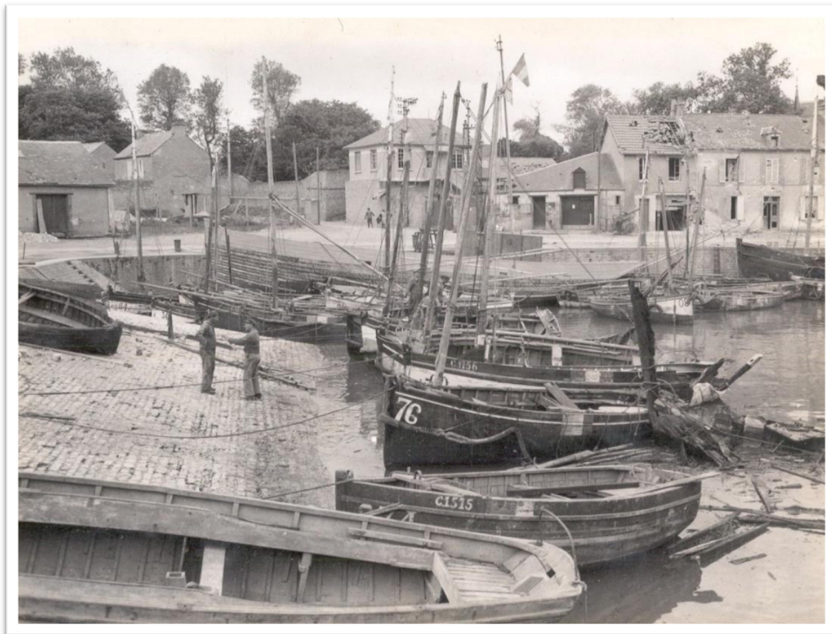
Doc 67 : Chaloupes dans le deuxième bassin de Port-en-Bessin, juin 1944 1532
