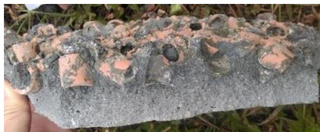
Photographie 5-10 : Les coques sont remplies par le béton de protection
