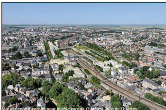
Vue aérienne du projet pour le pôle gare de Chartres - Ville de Chartres
