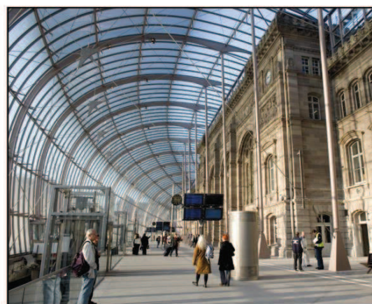
Figure n°6 - Photo de la verrière aménagée devant la façade historique de la gare de Strasbourg - Source : SNCF
