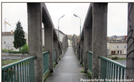
Passerelle de franchissement
