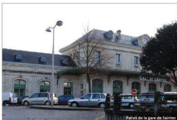
Parvis de la gare de Saintes
