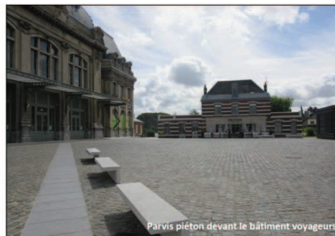
Parvis piéton devant le bâtiment voyageurs
