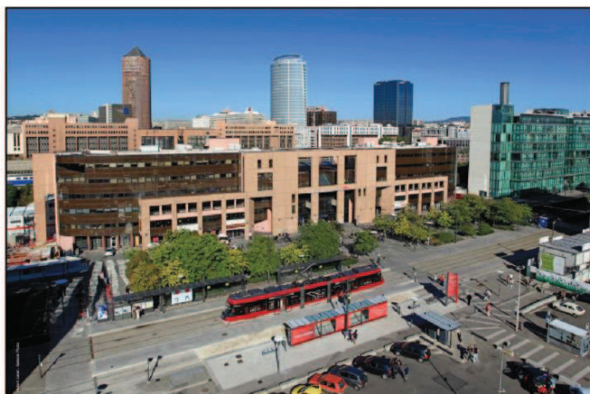
Figure n°5 - Le quartier d'affaires développé à proximité de la gare de Lyon Part-Dieu - Source : Agence Aderly - Invest in Lyon
