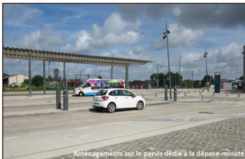
Aménagements sur le parvis dédié à la dépose-minute
