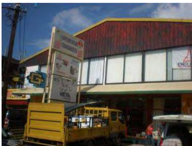
Figure 8 : Supermarché Transamérica, à Paramaribo (2011).
