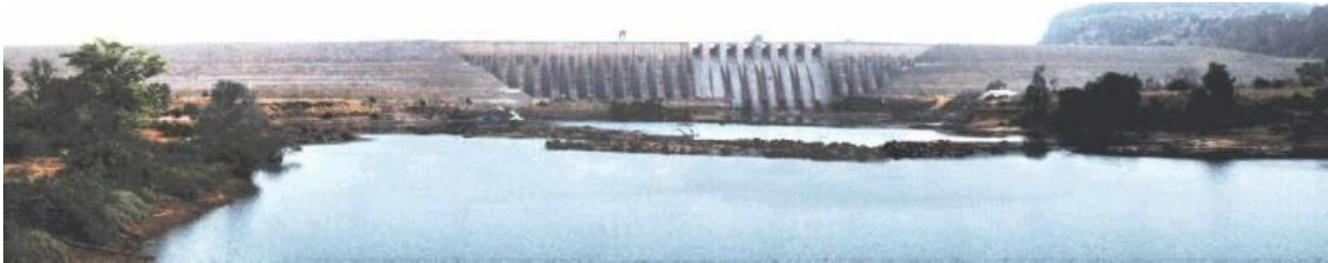
Figure 1.24 : Photographie du barrage hydroélectrique de Manantali au Mali (2008).
