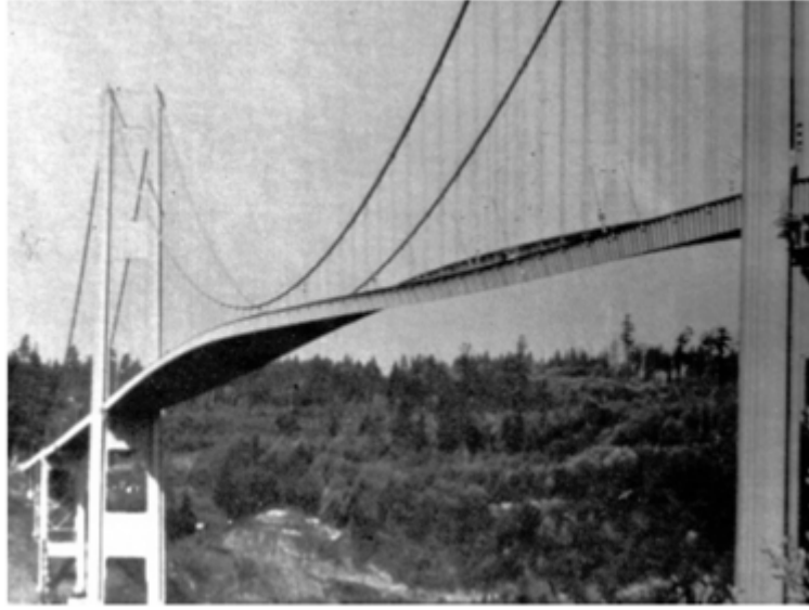
FIGURE 1.6 – Effondrement du pont de Tacoma [Farquharson, 1949]
