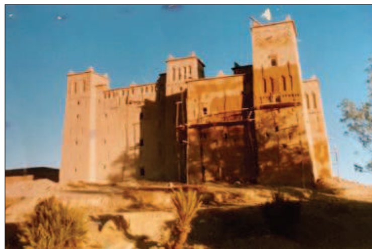
b- Après la restauration
