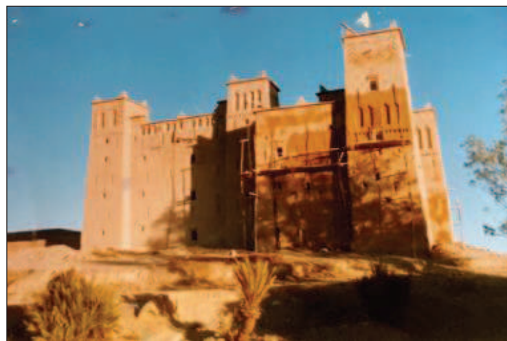
b- Après la restauration
