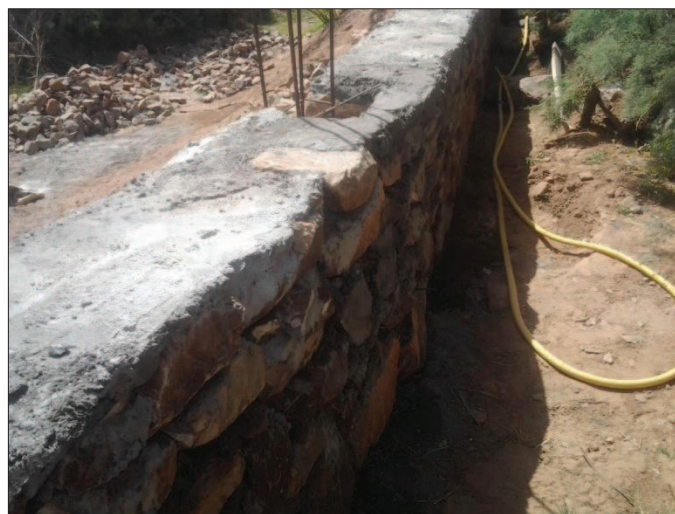
Photo 11- construction en cours d'un mûr contre la montée des eaux
