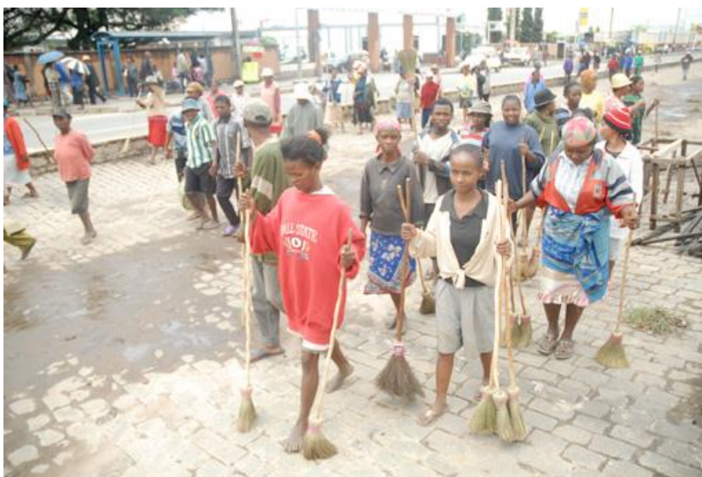
Photo 2 : exemple de travail HIMO lors de la construction d'une portion de route dans la Capitale Source : Archives personnelle, 2004
