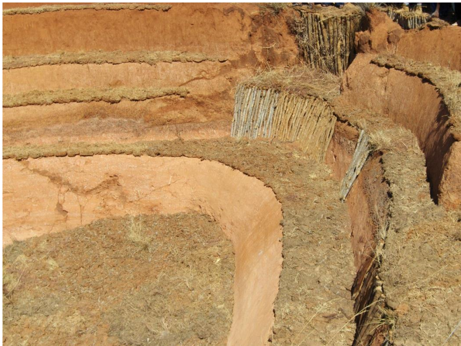
Photo 9 : Système de protection contre l'érosion Source : Archives personnelle, 2007
