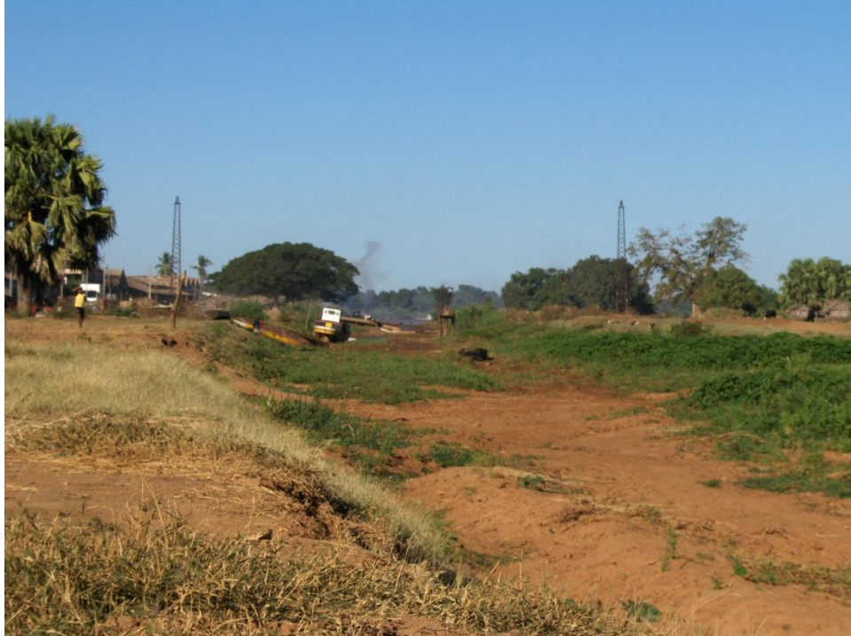
Photo 7 : Ensablement du port fluvial de la ville de Marovoay Source : Archives personnelle, 2007
