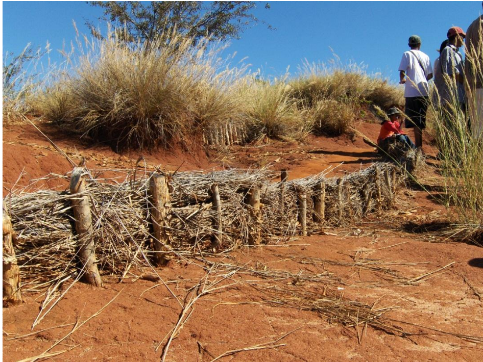
Photo 8 : Système mis en place pour lutter contre l'érosion Source : Archives personnelle, 2007
