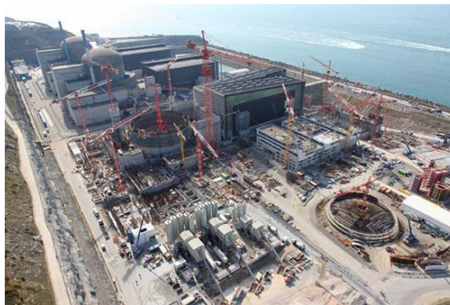
Figure I-1 : Chantier du réacteur EPR de Flamanville 3.
