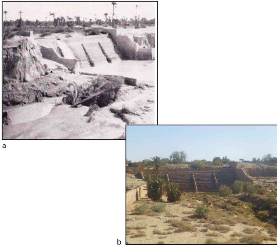
Fig.171 - Barrage d'Irara en 1940 (a), dans Monteil 1968 : 84 ; le même barrage en 2014 (b). Photos : T. Soubira, 2014. La datation de cet ouvrage est inconnue, Monteil signale dans ses notes que les habitants de la région parlent des Romains ( Rûm ) à qui l'on attribue habituellement au Tāfilālt tout ce qui est ancien.
