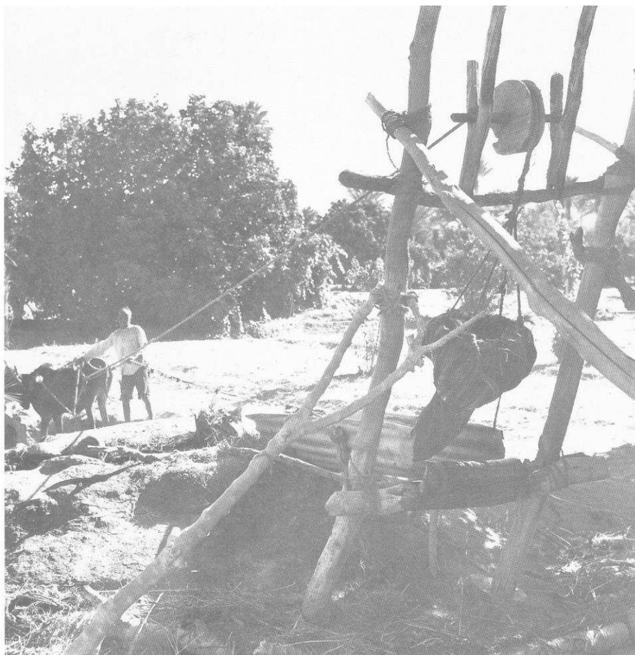
Fig.117 - Puits à poulie à traction animale en fonctionnement, dans Gast 1995 : 2262.
