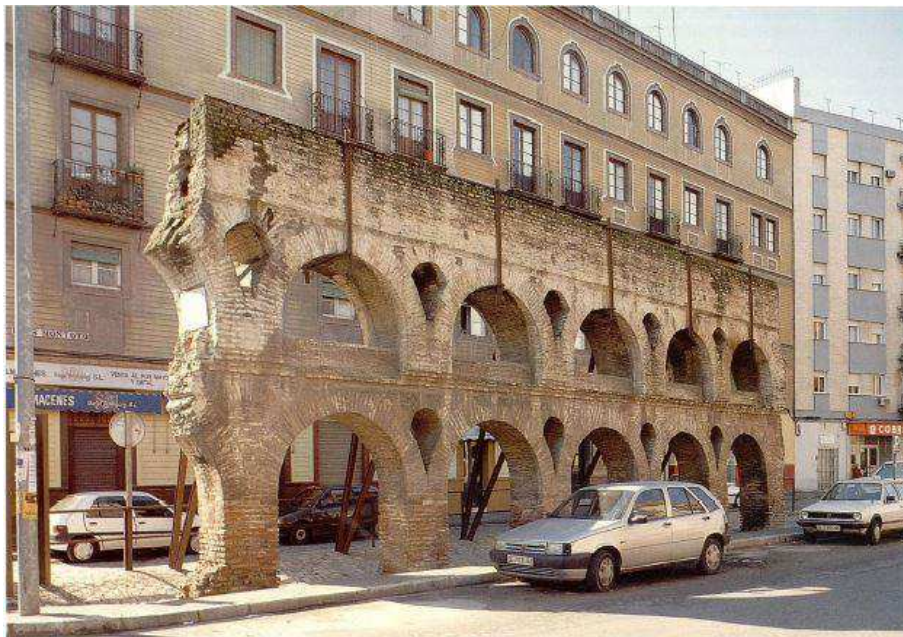
Fig.44 - Vestiges de l'aqueduc de los Caños de Carmona, dans Valor Piechotta et al. 1999 : 182.
