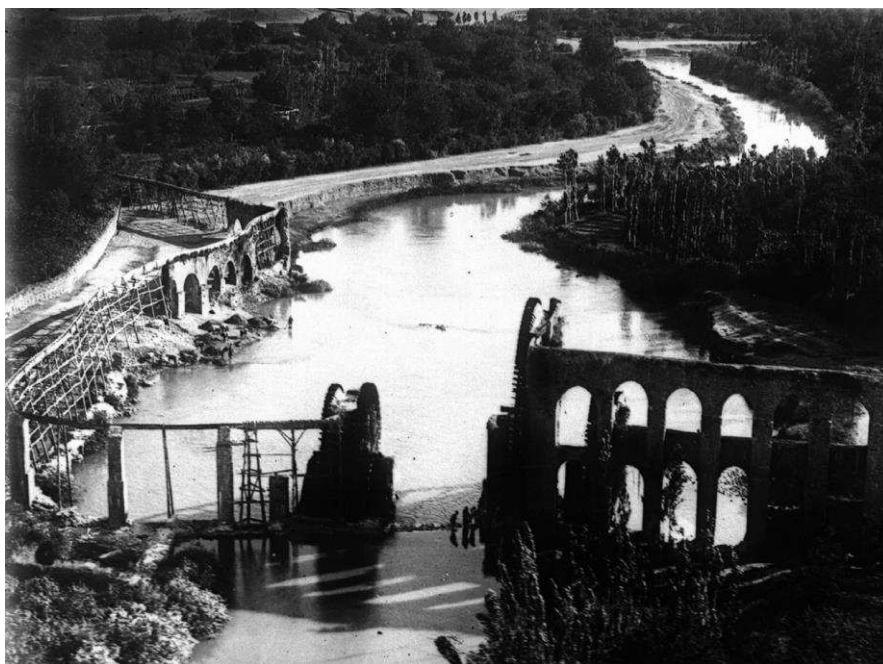
Fig.109 - Photographie de 1932 de deux nawā'ir sur l'Oronte dans les jardins de Ḥamāt et les aqueducs associés, dans Al Dbiyat 2009 : 202.
