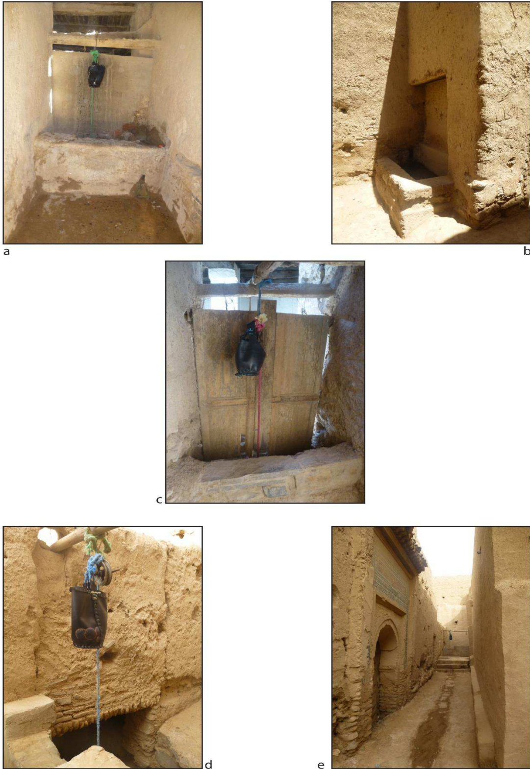
Fig.298 - Exemples de puits dans plusieurs kṣūr « courants » : à Wighlane (a et b), le puits est associé à un abreuvoir extérieur ; à Sosso (c), la structure est très caractéristique des puits urbains du Tāfilālt avec les deux espaces village et mosquée séparés par un pan de bois ; à Oulad Abd al-Halim (d et e), le puits est situé au fond d'une ruelle et attenant à la mosquée. Photos : T. Soubira, 2014.
