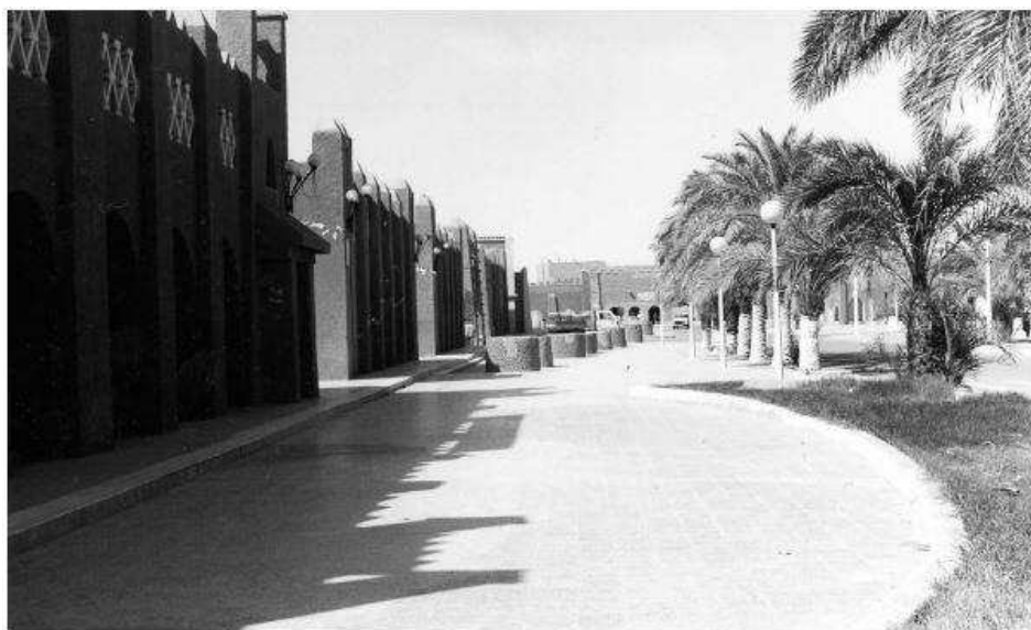
Fig.136 - Passage d'une foggara dans le centre-ville d'Adrar, dans Remini et Achour 2008b : 28.
