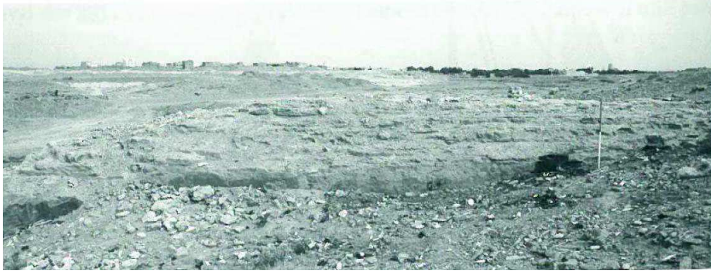
Fig.292 - Vestiges de la digue ancienne du Wādī Amerbouh en maçonnerie de moellons et mortier de chaux hydraulique, dans Capel 2016c : 150.
