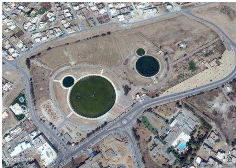
Fig.19 - Complexe des bassins d'al-Ḳayrawān.
