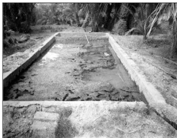
Fig.130 - Exemple de kasria dans l'oasis de Timimūn (a), dans Remini et al. 2011 ; Bassin cimenté de réception et de régulation du débit (b), dans Remini et Achour 2008b : 30.
