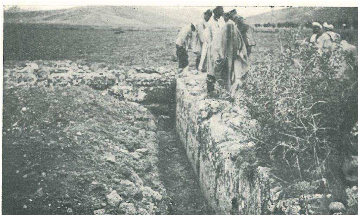
Fig.89 - Intérieur du bassin dans la région de Fès, dans Vicaire et Thouvenot 1938 : 369.
