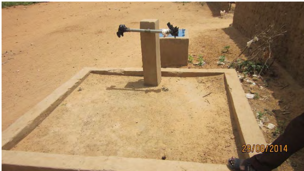
Photo 86 : un point d'eau construit par Moussa Morey au quartier Gouritchiri en 2014
