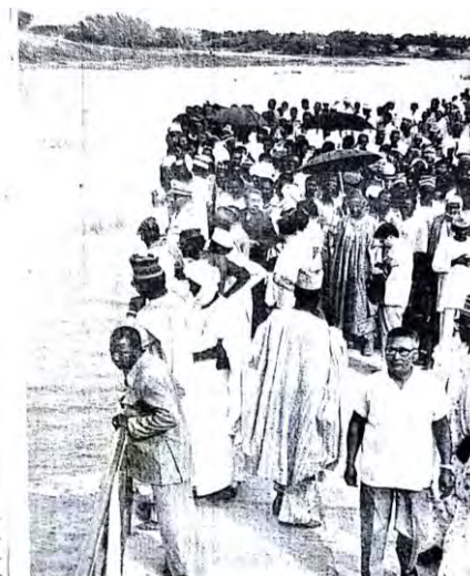
Photo 22 et 23 : le barrage-réservoir de Téra durant la construction en 1979 et lors de la réception de l'ouvrage en 1980
