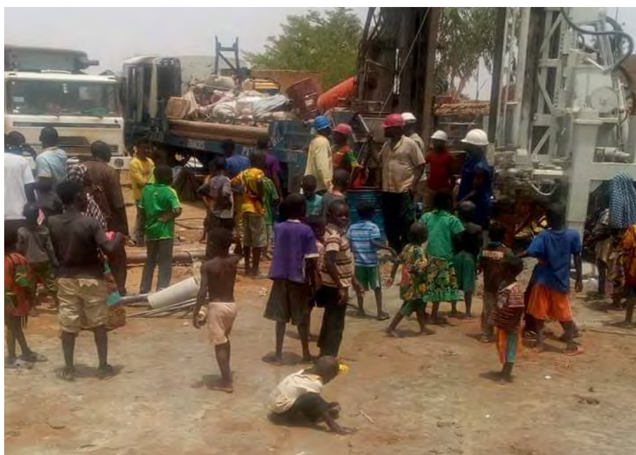
Photo 71 : l'émerveillement des enfants devant une opération de fonçage de forage dans le quartier Carré par l'entreprise Morey
