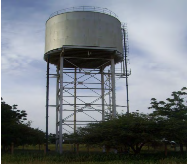
Photo 1 : le château d'eau de la ville de Téra
