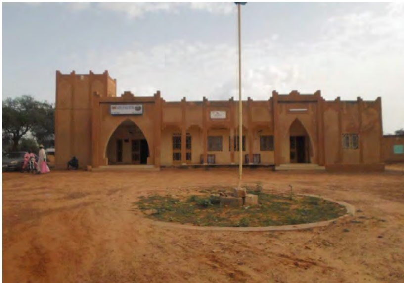
Photo 35 : les locaux de la commune urbaine de Téra, fruit de la coopération allemande (90 %) et de la coopération décentralisée avec Bonneville (10 %).
