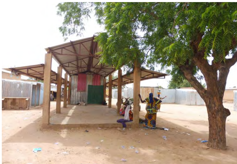
Photo 34 : le petit marché quasiment inoccupé après sa rénovation
