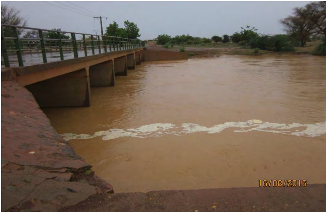
Photo 15 : le Dargol à Kakassi après une forte pluie avec des apports très chargés
