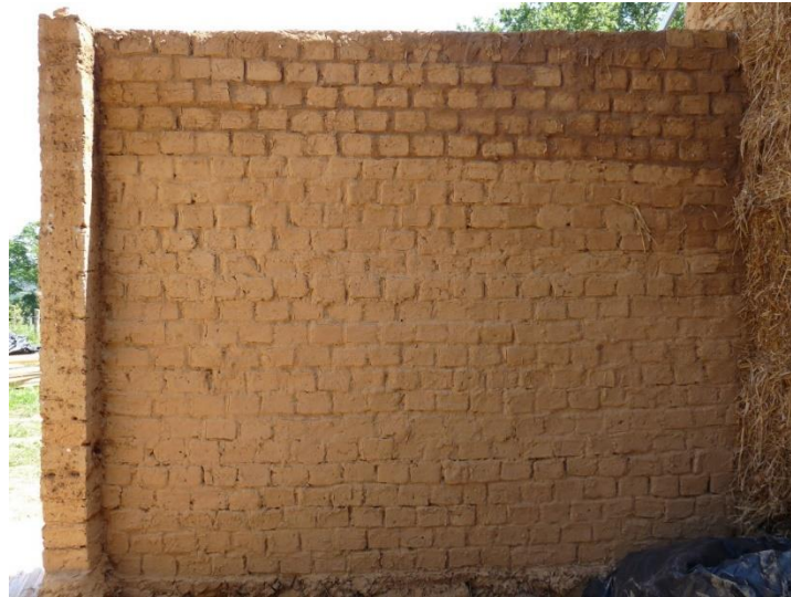
Figure 2.5 : Mur porteur en adobe ( http://www.lesguepesmaconnes.fr )
