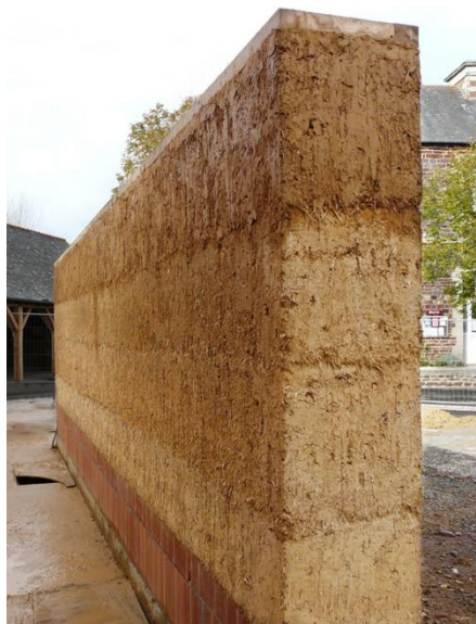
Figure 2.4 : Mur en bauge ( http://www.totem-terre-couleurs.fr )
