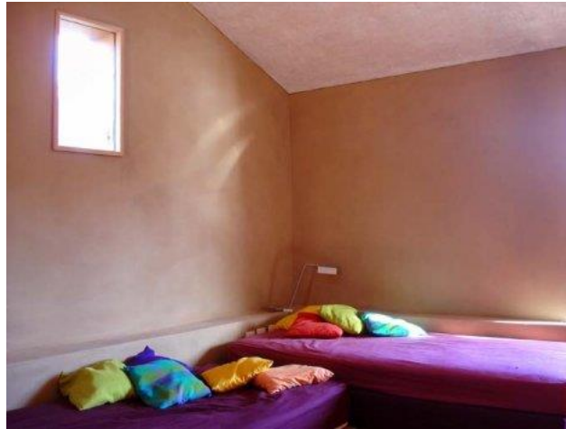
Figure 2.7 : Murs recouvert d'un enduit en terre crue ( http://www.asterre.org )
