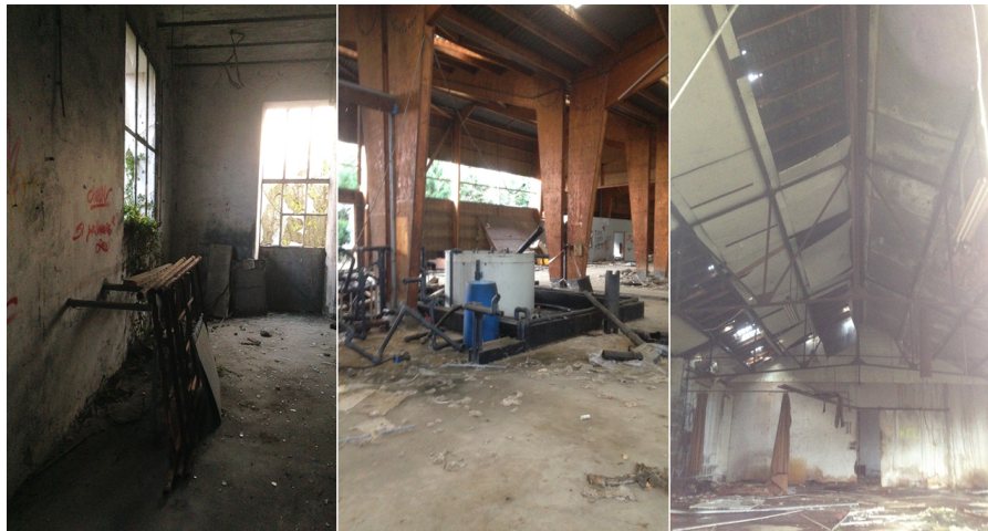
FIGURE F.2 – Photographies de l'intérieur des bâtiments de la friche de l'Alleud
